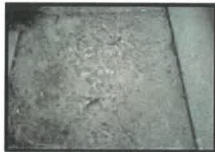
Spalling
